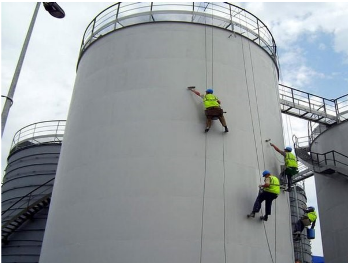
3.13-rasm. Rezervuarni himoya qilish(bo'yash) jarayoni
