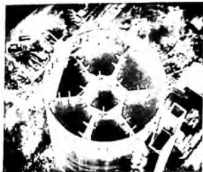
160 – rasm. Ko'p bo'linmali silos (qurilish jarayoni) [151.152]
