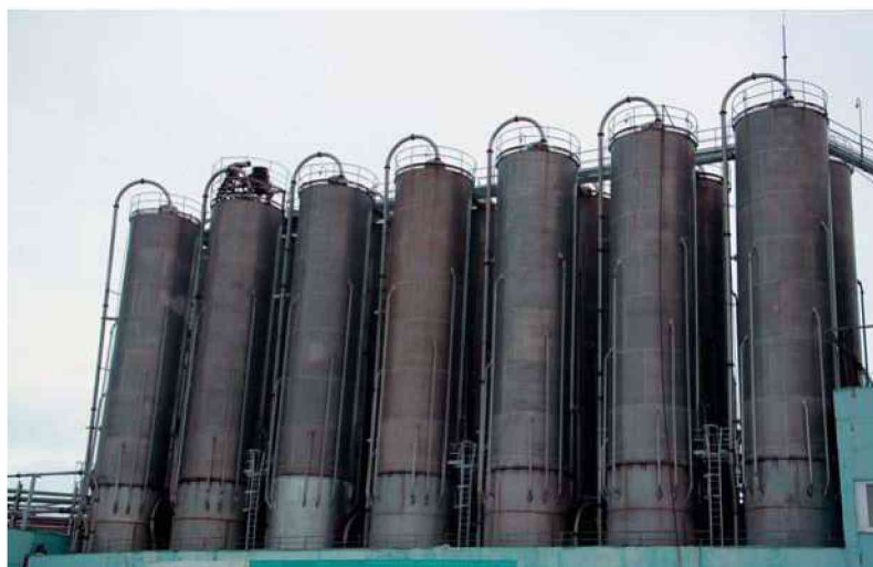
11.30 -rasm.. Propilenni granullash qurilmasini gomogenizatori montaj qilingan 2 qatori
