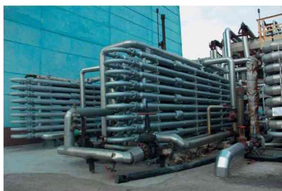
11.20 -rasm. Issiqlik almashinish apparati bo'lib, suv gaz yuqori bosimda u orqali o'tadi
