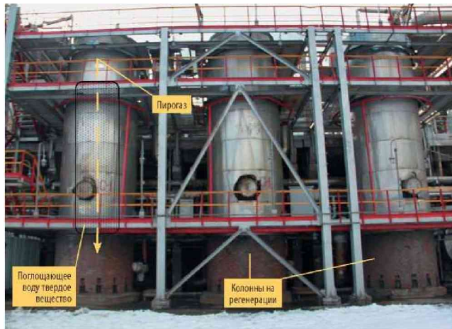
11.10-rasm. Pirogazni quritish kolonnalari
