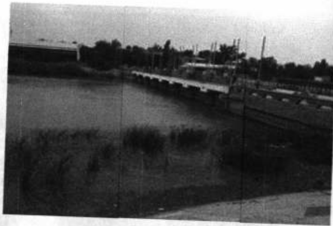
5.5 - rasm. Janubiy Mirzacho'l kanalining PK 145 dagi gidrouzelni yuqori b'efi o'zanida o'sgan suv o'tlari
