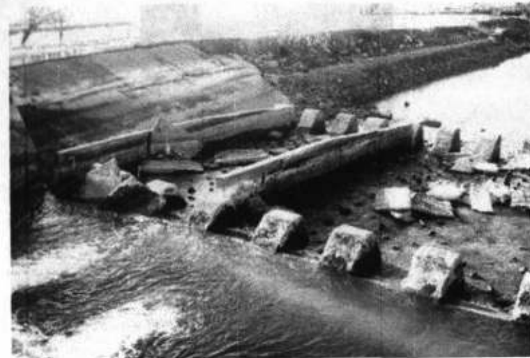
3.2 - rasm. Do'stlik kanalining PK 580 da joylashgan tashlama inshootni pastki befidagi abraziv yemirilishlar
