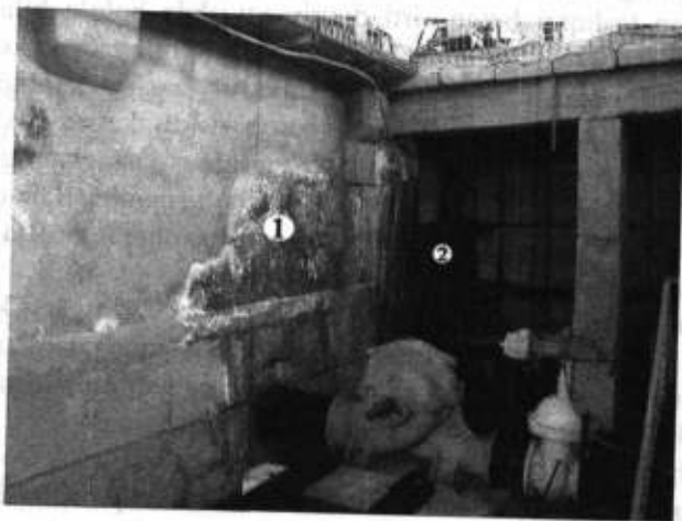
7.1- rasm. Nasos stansiyasi ichida devor sirtida hosil bo'lgan g'uborlanish (1) va oqish dog'i (2).
