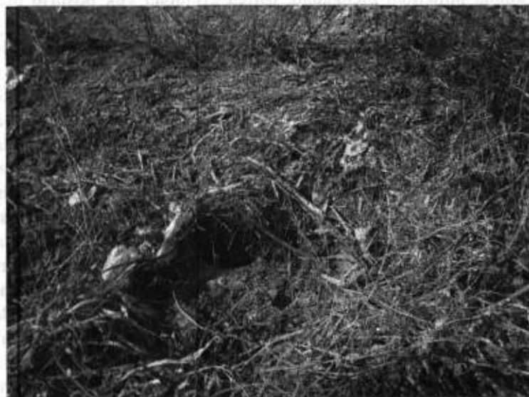
13.3 – rasm. Yumronqoziqning kanal dambasidagi ini.
