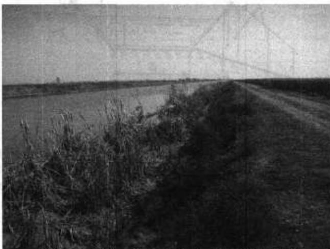
5.2 - rasm. Kanal qirg'og'ini o't bosish holati
