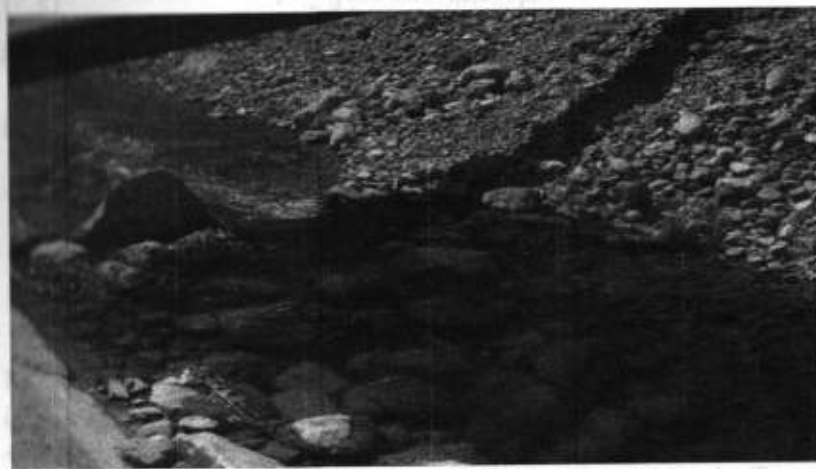
5.11 – rasm. Tog' yon-bag'ridan o'tgan kanal o'zanini tosh bosishi holati.
