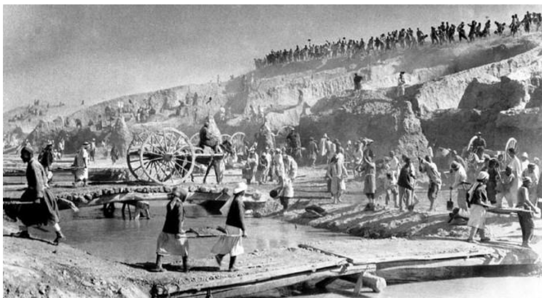
Katta Farg‘ona kanalini qurilish jarayoni. 1939 yil.
