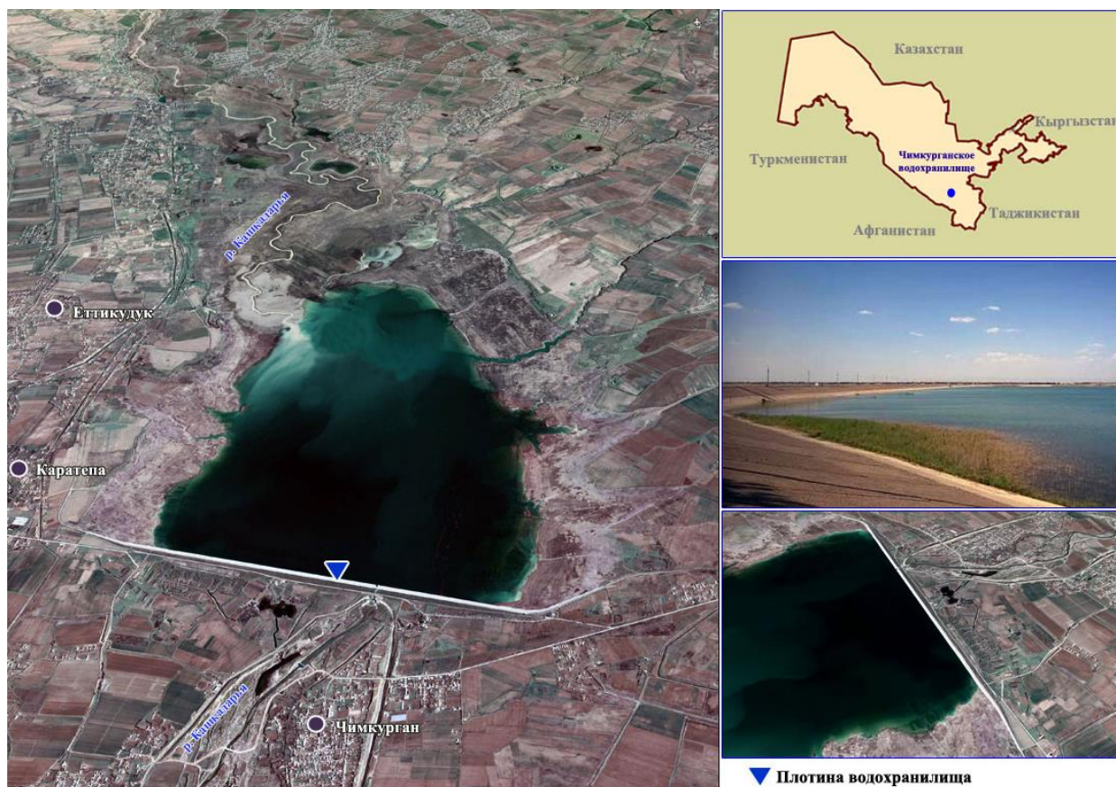
Chimqo'rg'on suv omborining umumiy ko'rinishi. 2018-yil.
