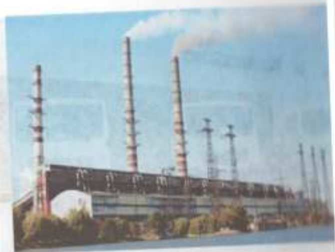
Рис.13. Сырдарьинская ТЭС вырабатывает до 10000 энергии.
