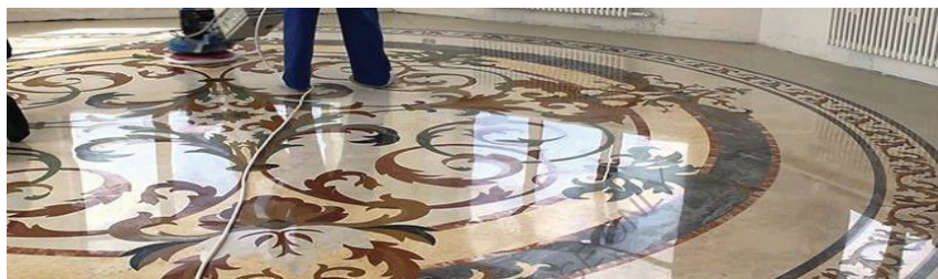
47-rasm. Mozaikali polni pardoqlash jarayoni
