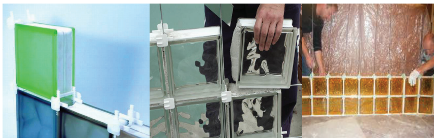
13-rasm. Shishabloklarni terish.
