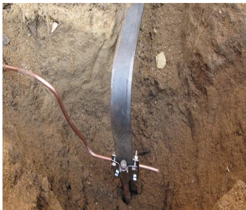
3.9 – rasm. Vertikal elektrodnlarni transheyaga o'rnatish qurilmasi
