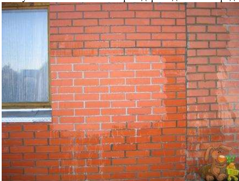
3.5-расм. Бино деворининг намлик ҳолатининг грунт намлиги туфайли бузилшига мисол [И.С. 27].
