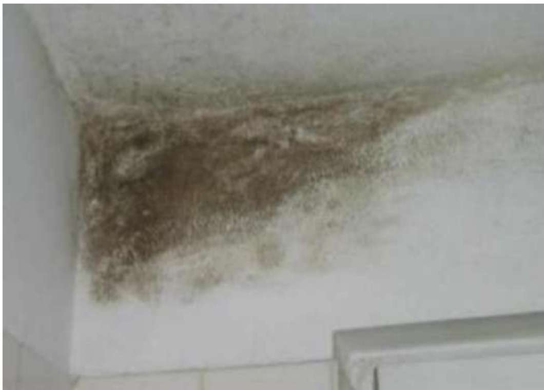
3.1-расм. Хона ташқи тўсиқ конструкциясининг намлик ҳолати бузилган ҳол [И.С. 24].
