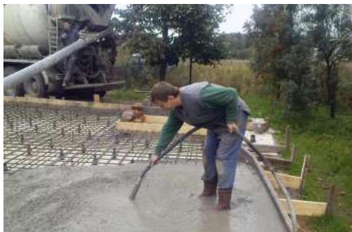
3.4-расм. Бинонинг яхлит пойдевор конструкциясини монолит бетондан барпо этилиши [И.С. 26].
