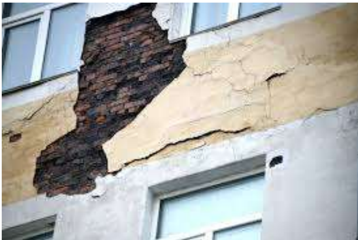
3.6-расм. Бино деворининг ҳолатига ёмғир сувлари таъсирининг оқибати [И.С. 28].
