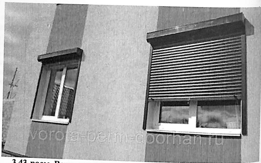
3.43-расм. Вертикал жалюза-экранлардан иборат қуёшдан химоялаш қурилмаси (Тошкент)
