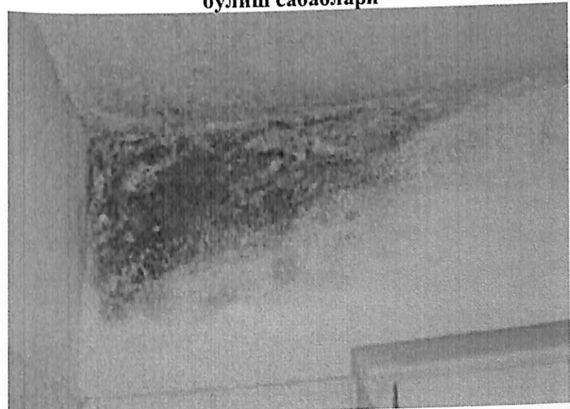
12.13-расм. Хона ташқи тўсиқ конструкциясининг намлик ҳолати бузилган ҳол
