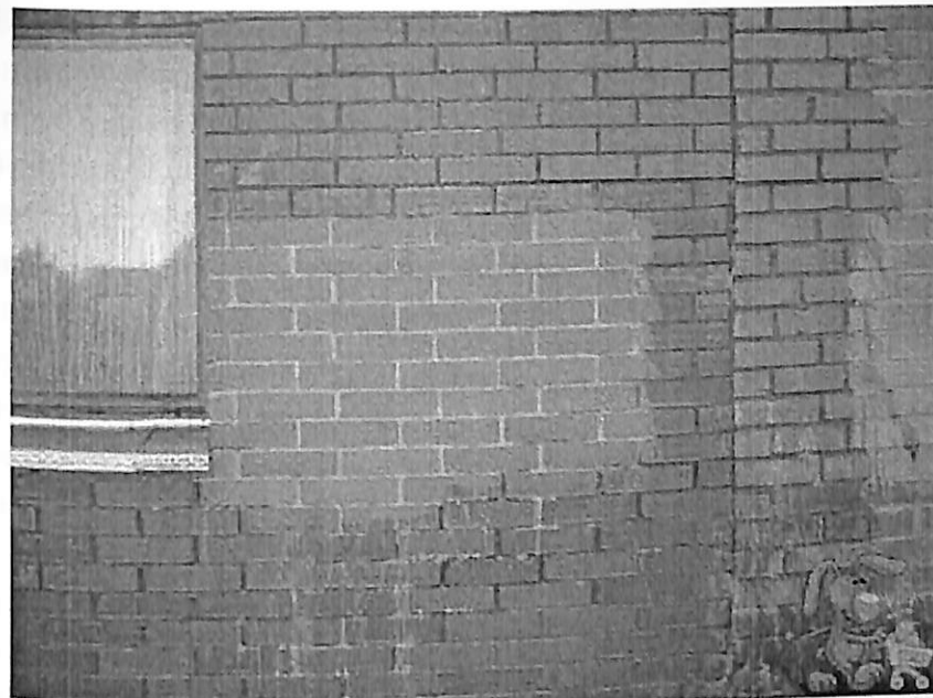
2.17-расм. Бино деворининг (ташқи тўсиқ конструкциясининг) намлик ҳолати бузилган ҳол
