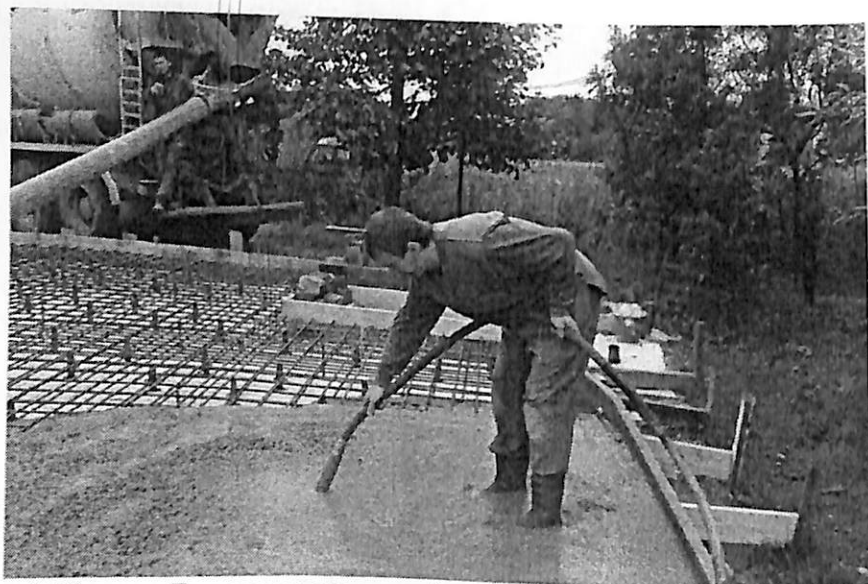
2.16-расм. Бинонинг яхлит пойдевор конструкциясини барпо этилиши
