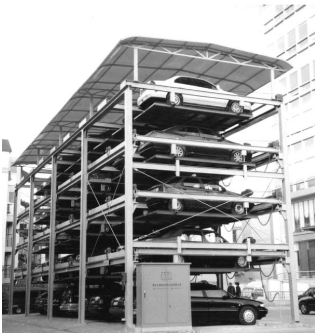
2.11-расм. Енгил конструктали автомобилни очик холда сақлаш жойлари а- ер сатхидан бошланадиган 5 қаватли сақлаш жойи;
