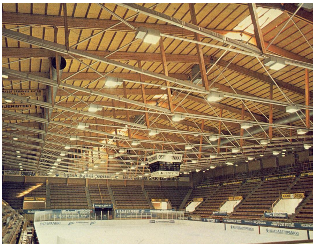
13.11-rasm. To'g'ri chiziqli tortqili arkalar bilan yopilgan sport saroyi binosi
