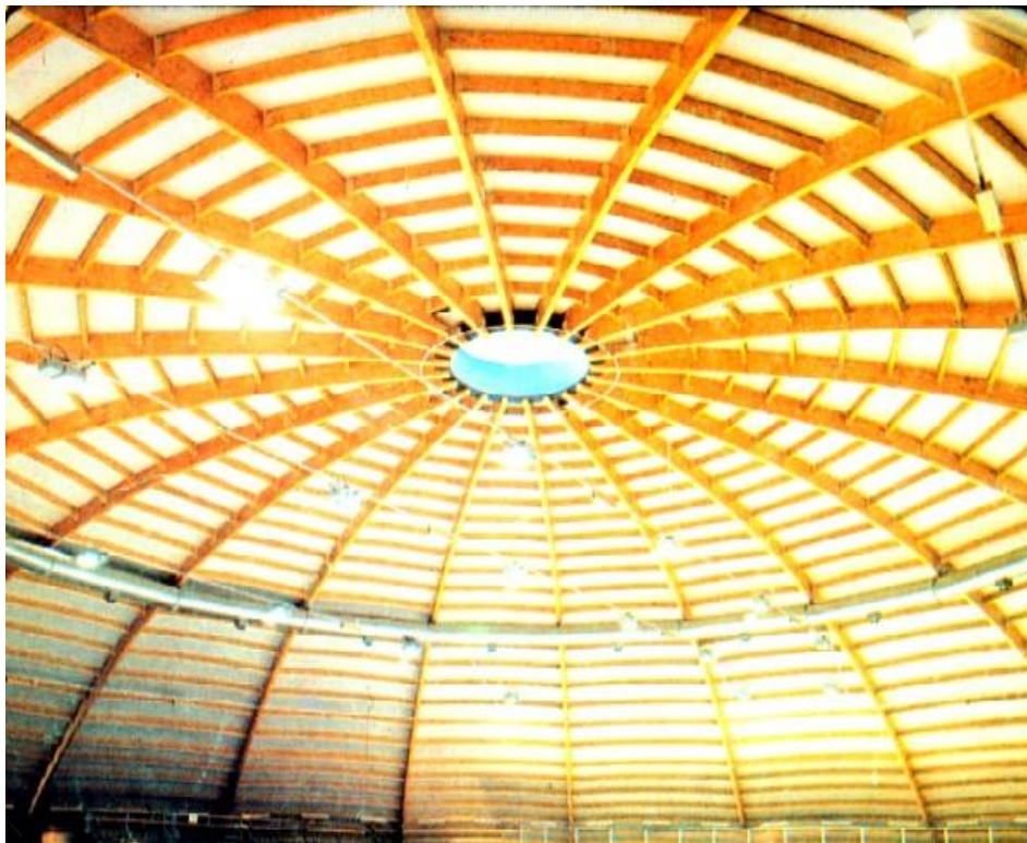
16.8-rasm. Yelimlangan elementlardan tayyorlangan qubbaning ko'rinishi
